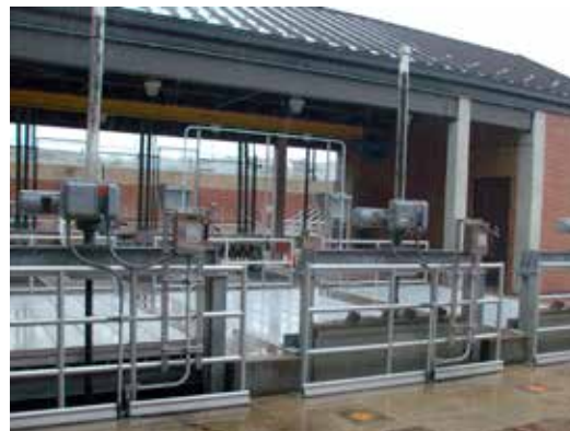
Effluent gates.
